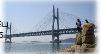
櫃石島斜張橋
