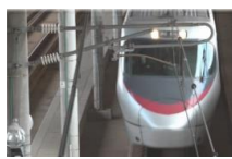
大浦通り跨線橋
